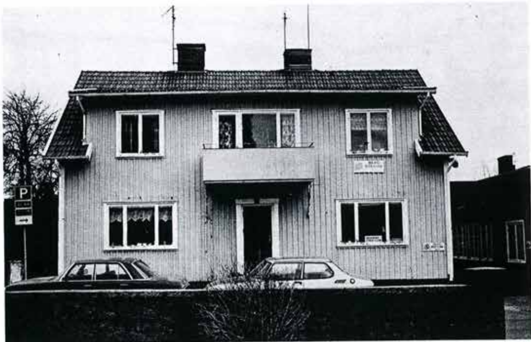
Svärdet 6. Bostadshus. Fasad mot Möllevägen. 1987. (Jämför äldre foto på sid 12)
