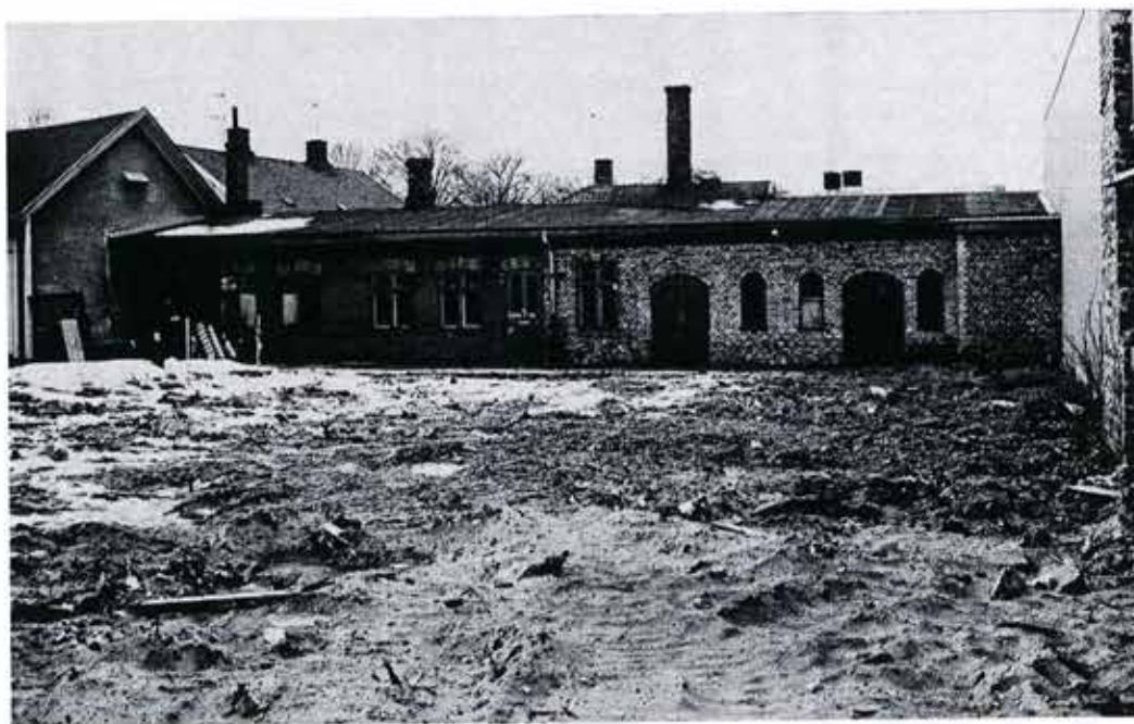
Svärdet 3. Lagerlokal i tegel. Fasadritningen (överst) gjordes 1919 av byggnadsfirman Landsten & Andersson och visar ett förslag till påbyggnad i trä som dock aldrig kom till utförande. Foto som visar samma fasad är taget 1987
