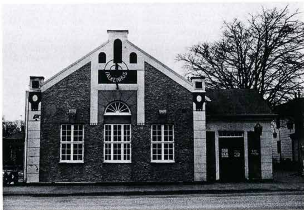
Gamla Folkets Hus. Huvudbyggnaden mot Holgersgatan uppförd 1914 Foto 1987
