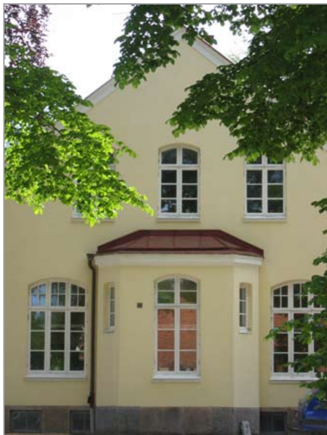
Ovan: F.d. Nybyhemmet. Till höger: Underläkarbostaden byggd 1952.
