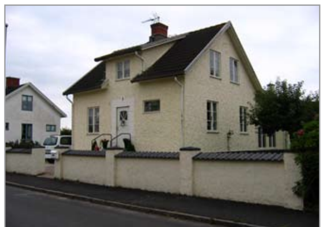
Nyttan 2 (Falkvägen 3). Uppfört för f. hushållerskan Emma Charlotta Skog. Falkenbergsputsen var ursprungligen vit, fönstren grönmålade och dörren mörkbrun med ospröjsad glasruta.
