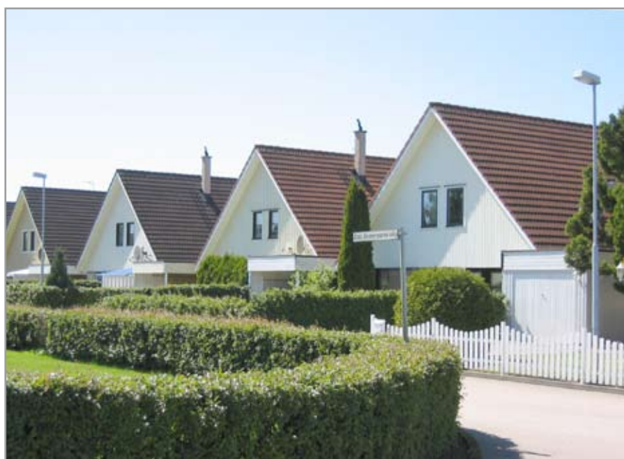
Överst: Det tilläggsisolerade kvarteret Kompassen på Västra gärdet. Till vänster: Villor på Slätten, Spelmannen 4 - 7.
