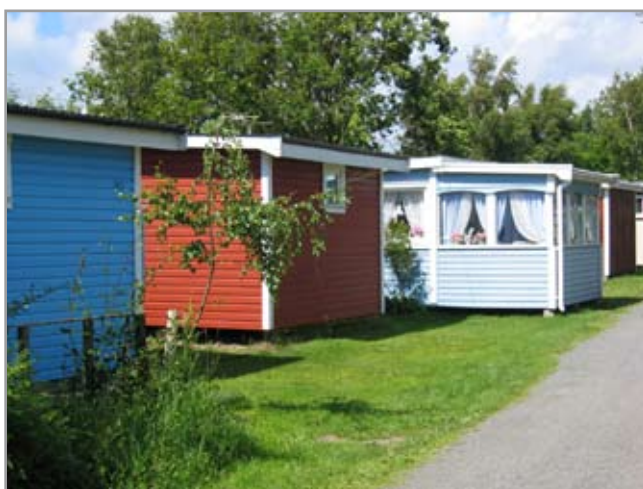
Knölaberget, exempel på inbyggd veranda.
