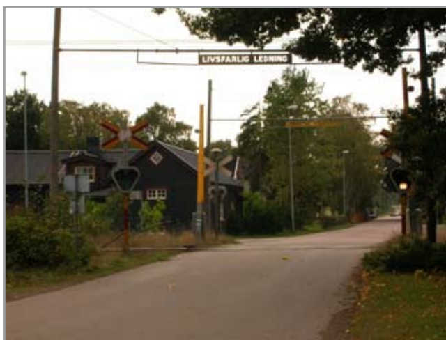
Järnvägsövergången från norr.
