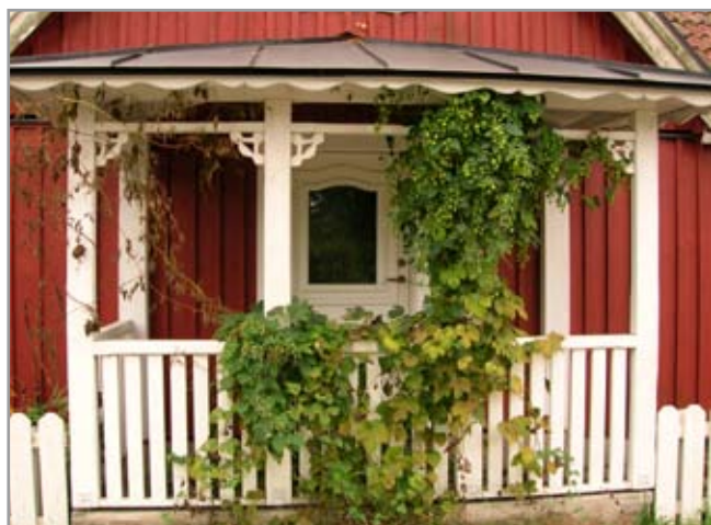
Verandan på huset vid Albertinavägen.
