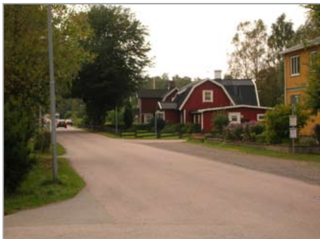
Skrea stationsväg från nordost.
