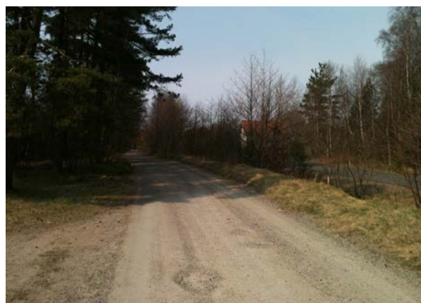
Område 3 befintlig grusväg (Albertinas väg)
